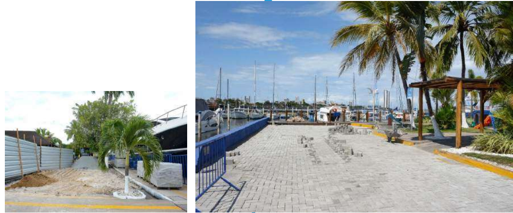
Troca de Piso intertravado
